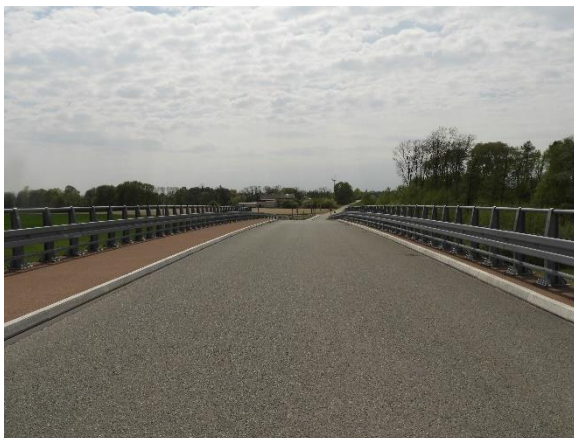
Fot. 12 Droga gminna nr 190911C w Unisławicach
