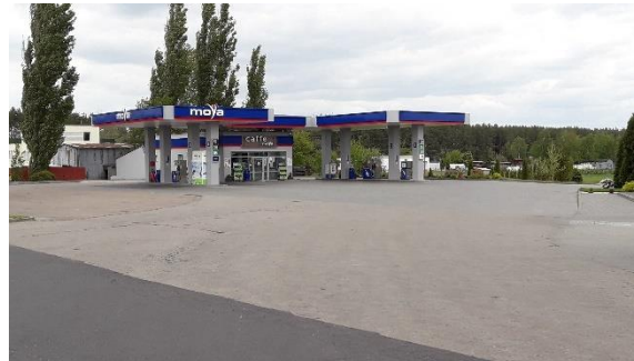
Fot. 15 Stacja paliw w Przydatkach Gołaszewskich
