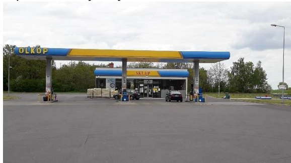
Fot. 14 Stacja paliw w Unisławicach
