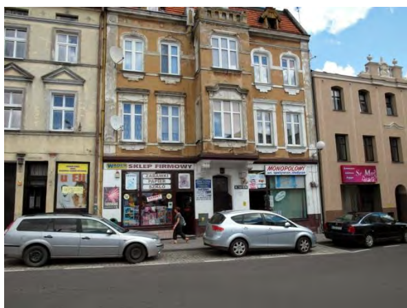
Fot. 194. Kamienica przy placu 700-lecia wymagająca odnowienia (fot. P. Rutkowski)
