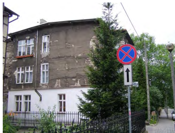
Fot. 104. Kamienica przy ul. Rybaki (fot. M. Murawska)
