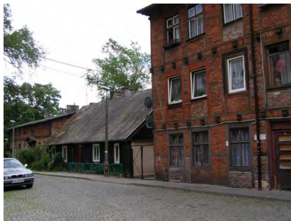
Fot. 90. Budynki szachulcowe przy ul. Rybaki (fot. M. Murawska)
