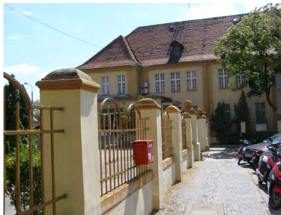
Fot. 156. Zabudowania wojskowe przy ul. Sobieskiego (fot. M. Murawska)
