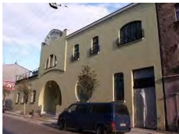
Fot. 13. Miejskie Centrum Kultury po rewitalizacji (fot. www.skycrapercity.com )
