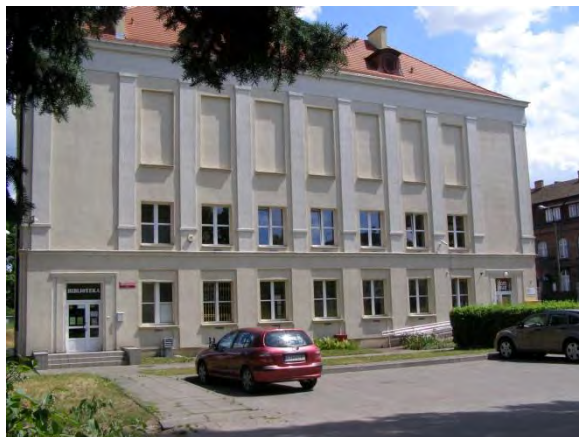
Fot. 106. Dom Muz i Biblioteka przy ul. Poznańskiej (fot. M. Murawska)
