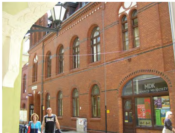
Fot. 120. MDK po remoncie (fot. M. Murawska)
