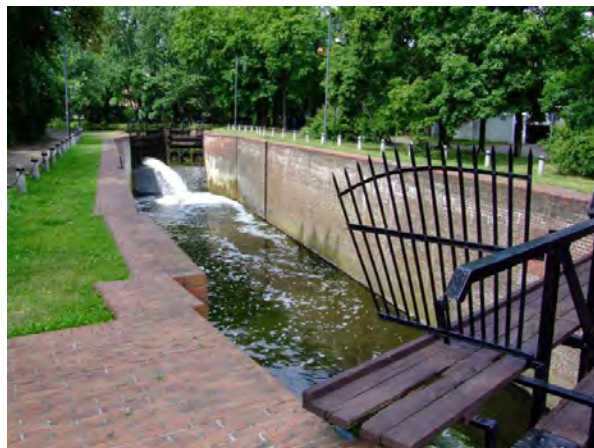
Fot. 67. Śluza na Kanale Bydgoskim (fot. P. Rutkowski)
