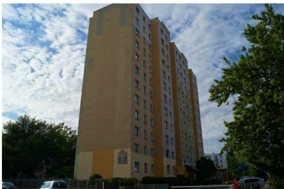
Fot. 91. Zabudowa z wielkiej płyty z połowy lat 70-tych przy ul. Słowackiego (fot. M. Murawska)
