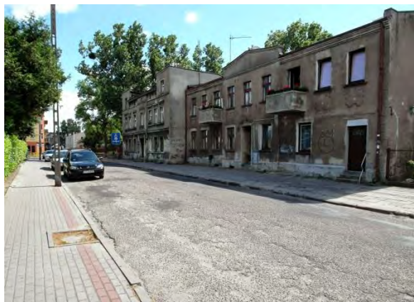
Fot. 171. Zniszczone budynki mieszkalne przy ulicy Chelmińskiej i Generała Józefa Hallera (fot. P. Rutkowski)
