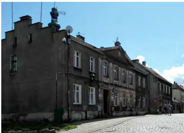
Fot. 170. Zniszczone budynki mieszkalne przy ulicy Chelmińskiej i Generała Józefa Hallera (fot. P. Rutkowski)
