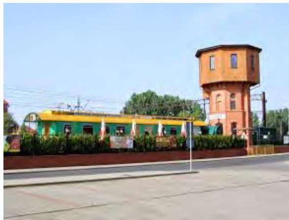
Fot. 182. Wieża ciśnień (fot. P. Rutkowski)
