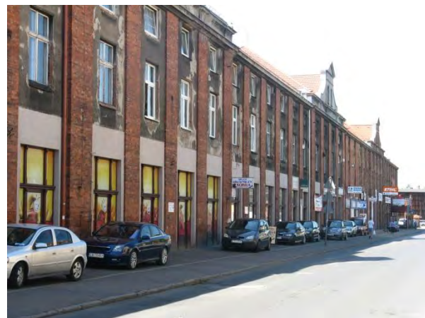
Fot. 54. Obiekt po „Kobrze” (fot. J. Korpala)
