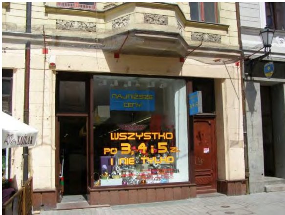
Fot. 125. Jeden ze sklepów przy ul. Szerokiej z nieestetycznym szyldem
