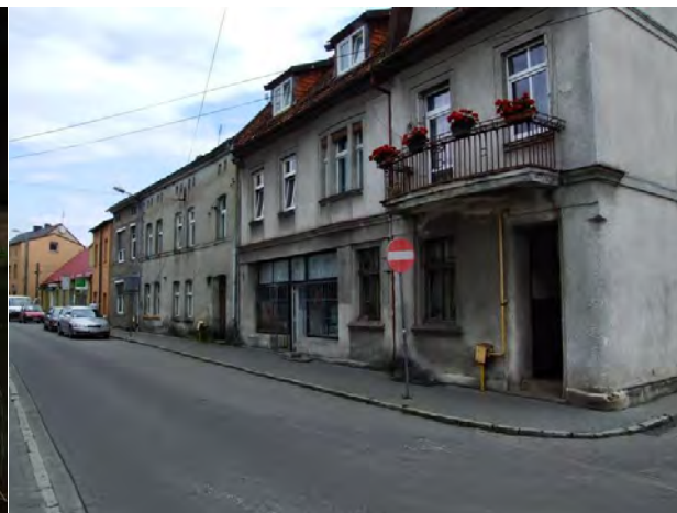
Fot. 191. Kamienice wymagające remontu (fot. P. Rutkowski)
