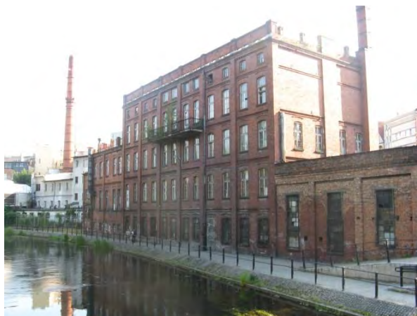
Fot. 29. Budynek Pralchem (fot. J. Korpala)
