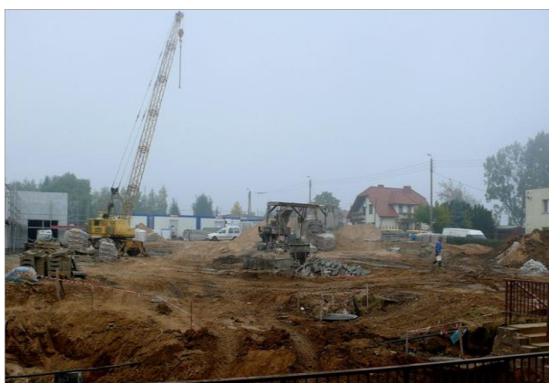
Fot. 20. Centrum Rekreacji i Sportu w budowie (fot. www.radiopik.pl )
