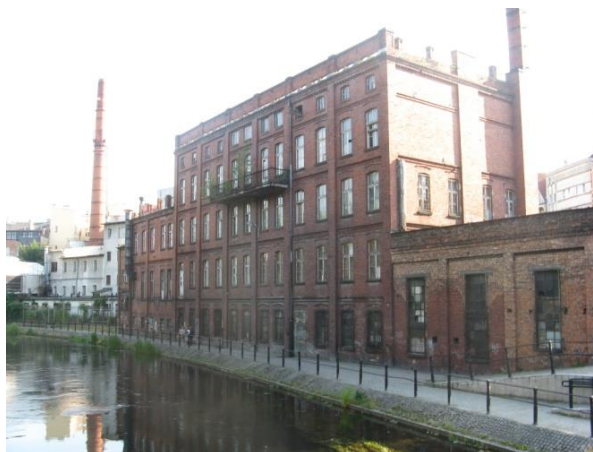
Fot. 29. Budynek Pralchem (fot. J. Korpala)
