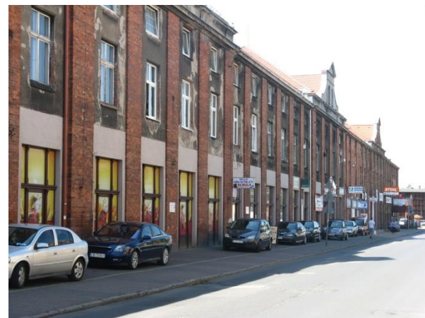
Fot. 54. Obiekt po „Kobrze” (fot. J. Korpala)
