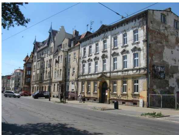
Fot. 57. Ulica Gdańska (fot. J. Korpala)
