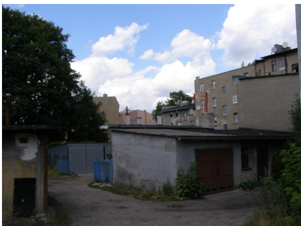
Fot. 117. Bezpośrednie otoczenie kamienic przy ul. Inowrocławskiej (fot. M. Murawska)
