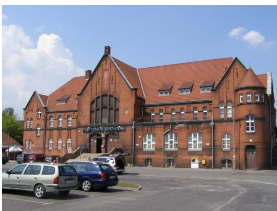
Fot. 131. Budynek dworca Toruń Wschodni (fot. M. Murawska)
