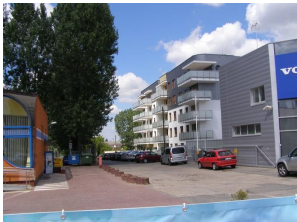
Fot. 145. Budynek mieszkalny na terenie po chłodni – widok od ul. Lubickiej (fot. M. Murawska)
