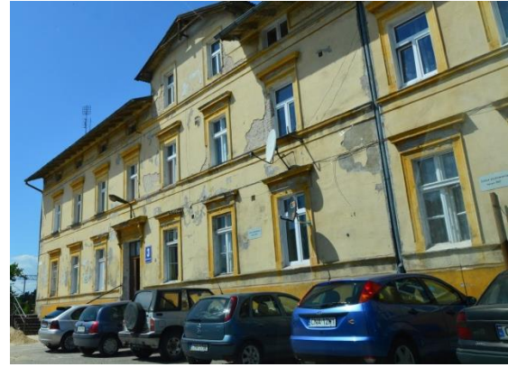
Fot. 161. Budynek po kolejowy przy ulicy Dworcowej 3 (fot. P. Rutkowski)
