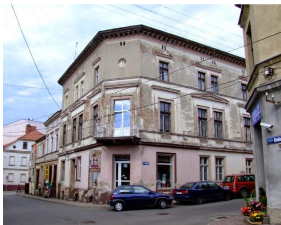
Fot. 165. Kamienica przy ul. Szkolnej (fot. P. Rutkowski)
