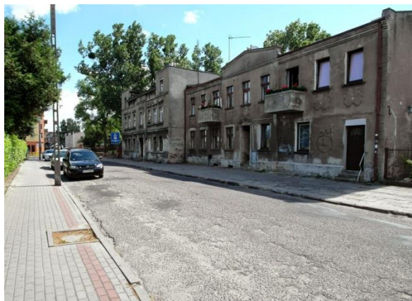
Fot. 171. Zniszczone budynki mieszkalne przy ulicy Chelmińskiej i Generała Józefa Hallera (fot. P. Rutkowski)
