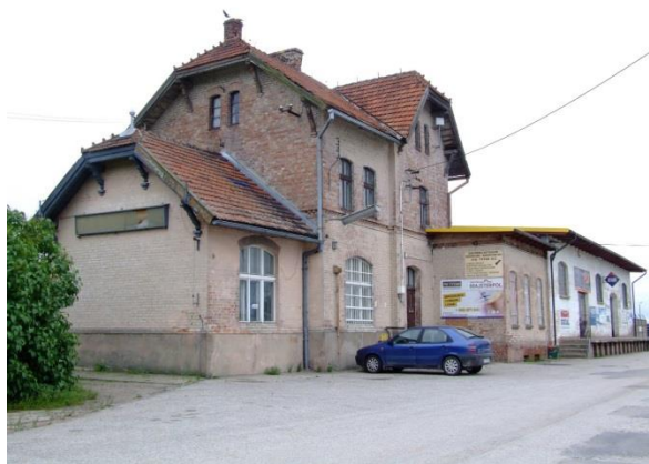
Fot. 195. Budynek dworca kolejowego (fot. P. Rutkowski)
