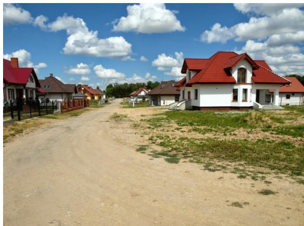
Fot. 196. Brak infrastruktury drogowej na osiedlu domków jednorodzinnych (fot. P. Rutkowski)
