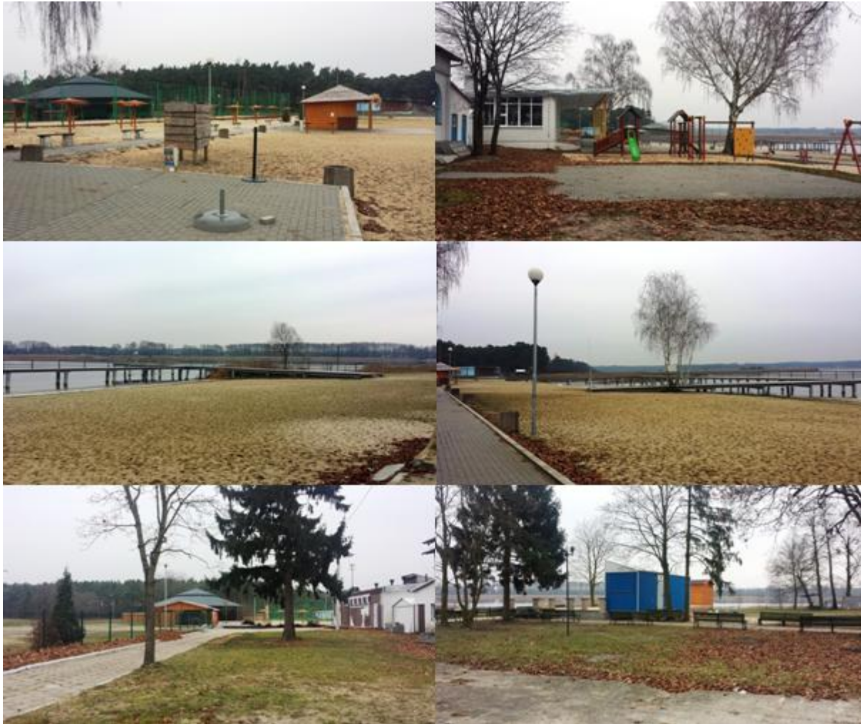
Zdjęcie 43. Aktualne zagospodarowanie terenów położonych nad Jeziorem Jezuickim w Chmielnikach
