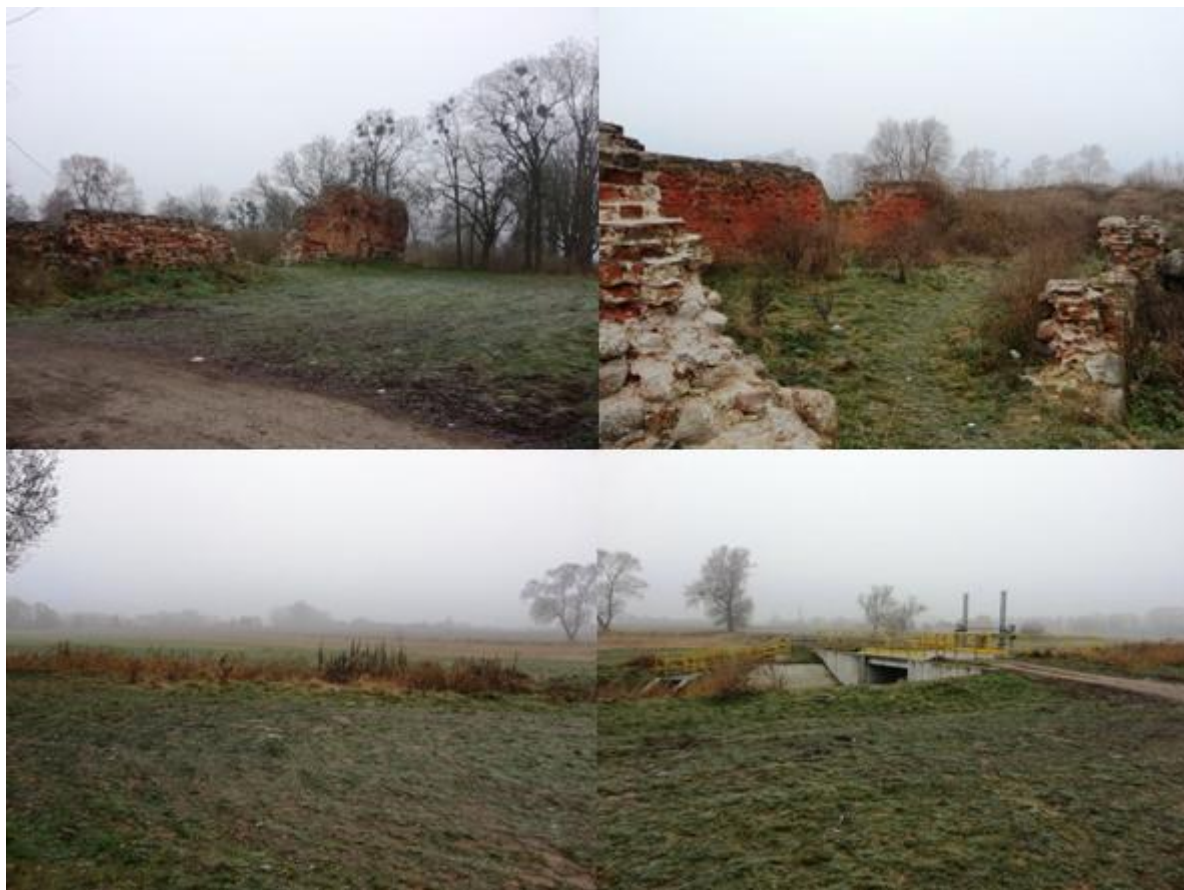
Zdjęcie 55. Aktualne zagospodarowanie obszaru objętego opracowaniem (rejon ruin zamku Sędziwoja)
